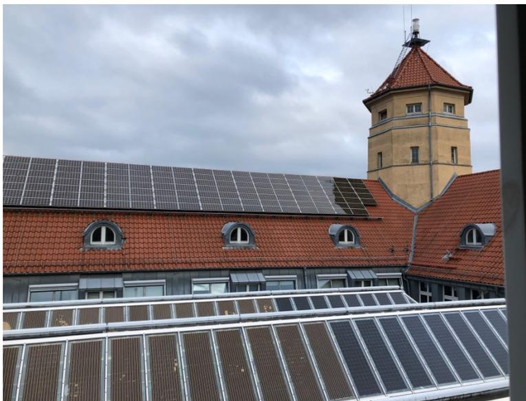
*Photovoltaikanlage (auf Dach und in Dach) auf dem ZKM*
