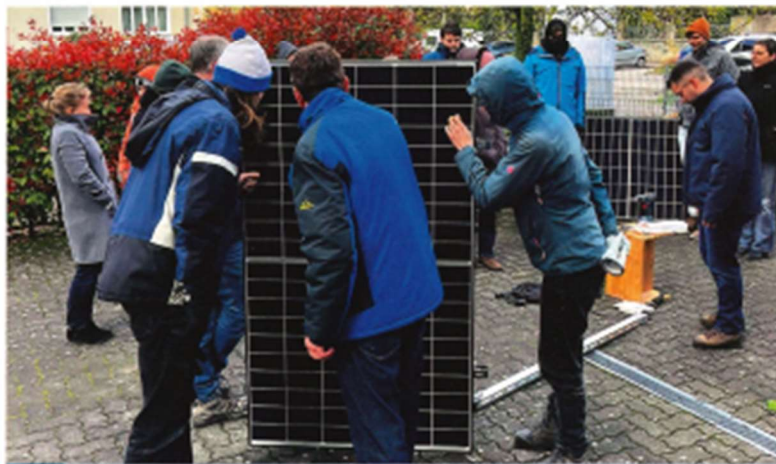
Selbstbau-Workshop des KAT mit ausgerichteten Photovoltaik-Modulen
