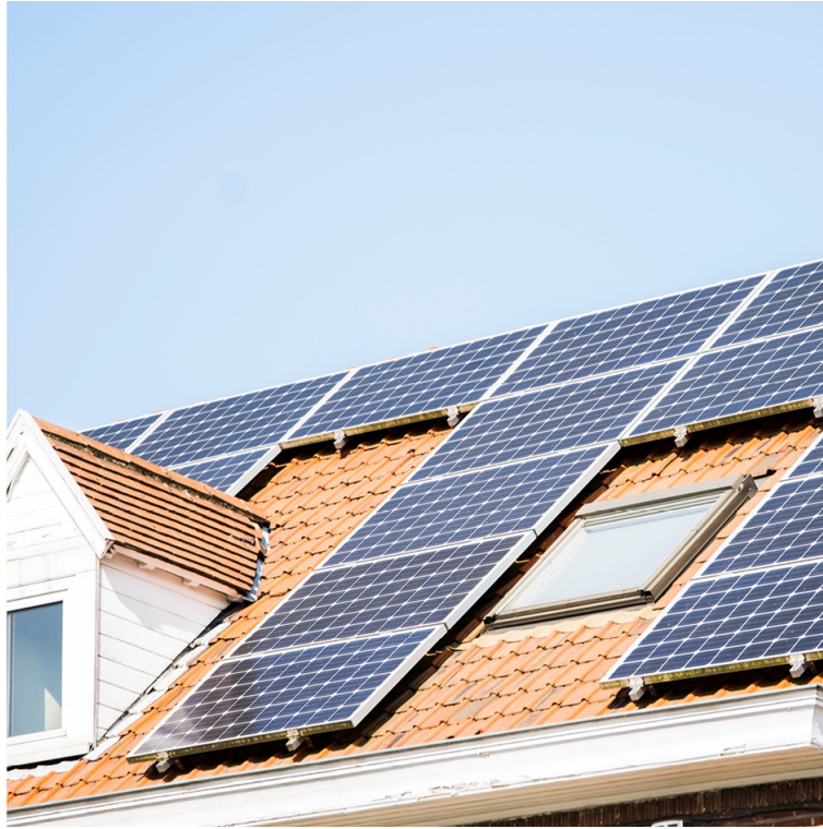
Abbildung 9: Photovoltaikanlage mit farblich auffallenden Rahmen, Rastermuster und Lücken als Negativ-Beispiel aus Sicht des Denkmalschutzes, Quelle: [18].
