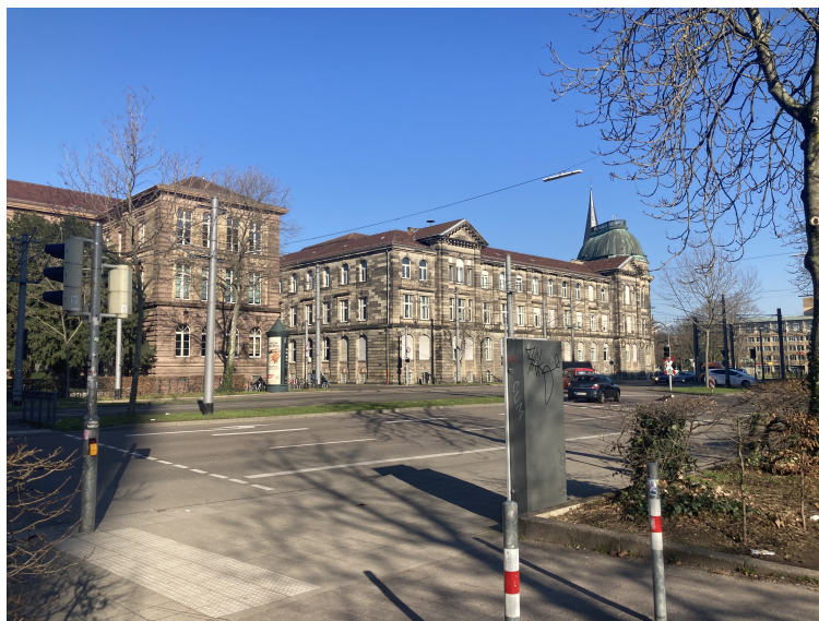
Abbildung 11: Foto vom Rathaus West, aus Süden von der Kaiserallee aus.
