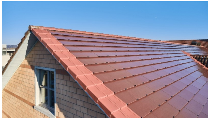
Abbildung 14: Photovoltaikziegel MATCH tile M65-HC24 terracotta A5 N|, Quelle: [20].
